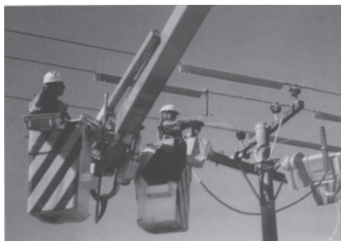
Figura 9.6. Trabajo en equipo (trabajo bajo tensión)
